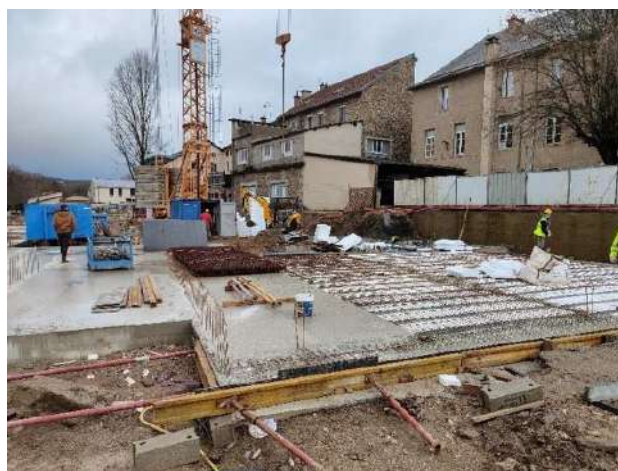
Début 2023, coffrage des dalles avec des hourdis polystyrène isolants. Coulage dans la foulée.
