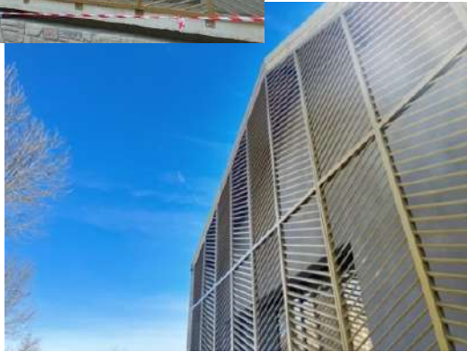
Installation des claustras extérieurs, éléments pare-soleil et esthétiques.
