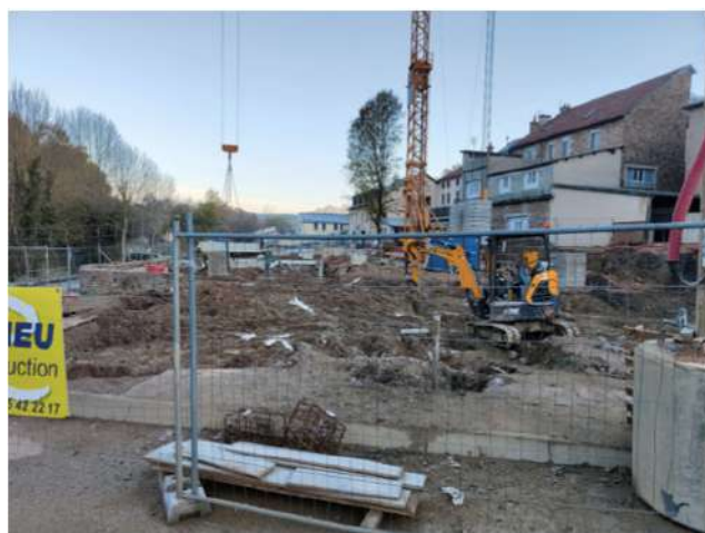
Fin 2022, lancement des travaux de terrassement. Les fondations sont coulées.
